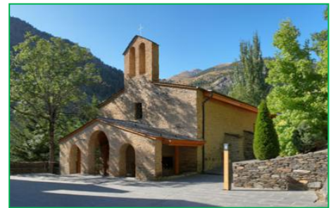
El antiguo santuario de Meritxell, rehabilitado en 1994
